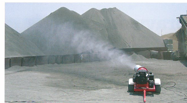
Snížení prašnosti v zastavěných oblastech při stavební činnosti
