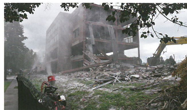
Fukar Buffalo s dieselovým motorem vytváří vodní clonu do výšky 30m, která padá dolů a sráží na zem vzniklý prach včetně jemných mikročástic.
